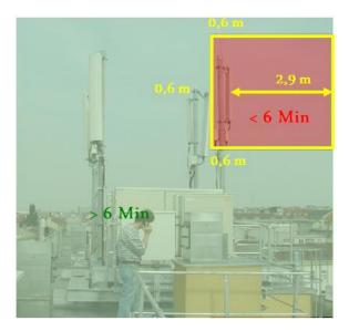
Grün markiert ist der zulässige Bereich für einen dauerhaften Aufenthalt (= länger als 6 Minuten). Innerhalb des roten Bereiches ist ein kurzfristiger Aufenthalt – beispielsweise für das Vorbeiklettern/Vorbeisteigen an der Antenne oder das Durchgehen durch den Bereich – möglich.
