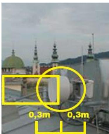
5. Auf Basis der Bestimmungen der ÖNORM E8850 ist ein Aufenthalt von beruflich exponierten Personen innerhalb der oben angeführten Sicherheitsabstände für die Dauer von max. 6 Minuten zulässig.
